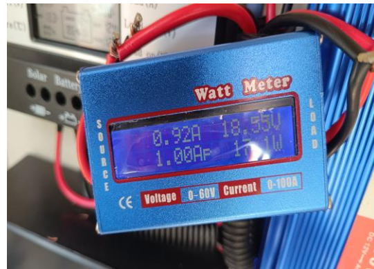
Pengukuran dengan Watt meter
