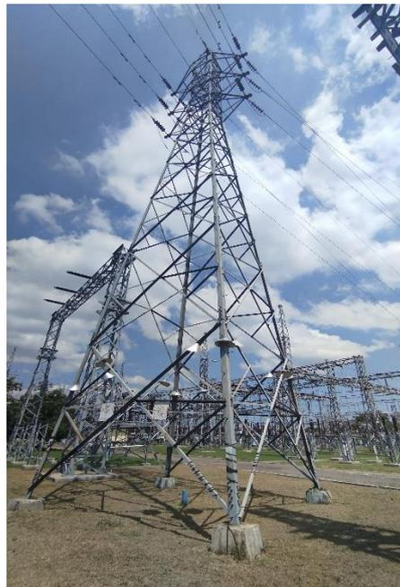
**Gambar 2. 2** Saluran Udara Tegangan Tinggi (SUTT)
